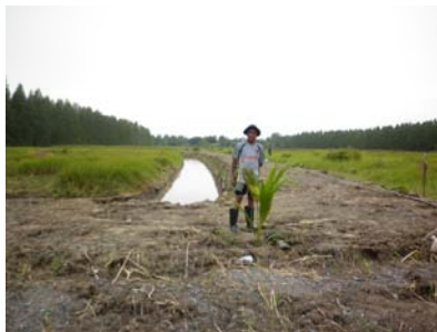
ปรับปรุงแปลงนาลักษณะที่ 2 (ขุดคูรอบแปลงนา)
